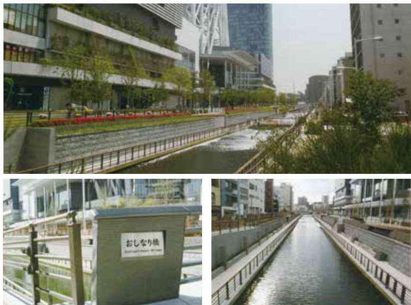
北十間川 護岸整備(スカイツリー前)
