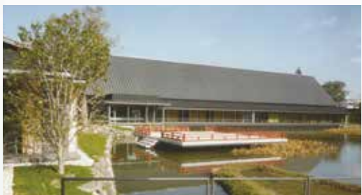
伊勢神宮 外宮 せんぐう館 新築工事
